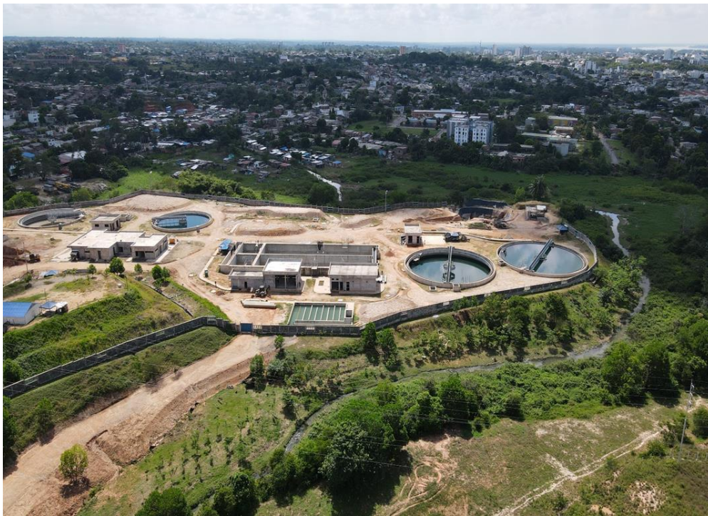
Fotografía Planta de Tratamiento PTAR San Silvestre
